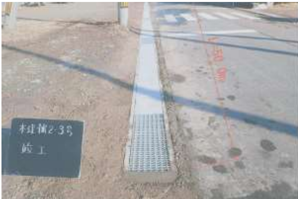
高千小 道路脇に側溝の施工
